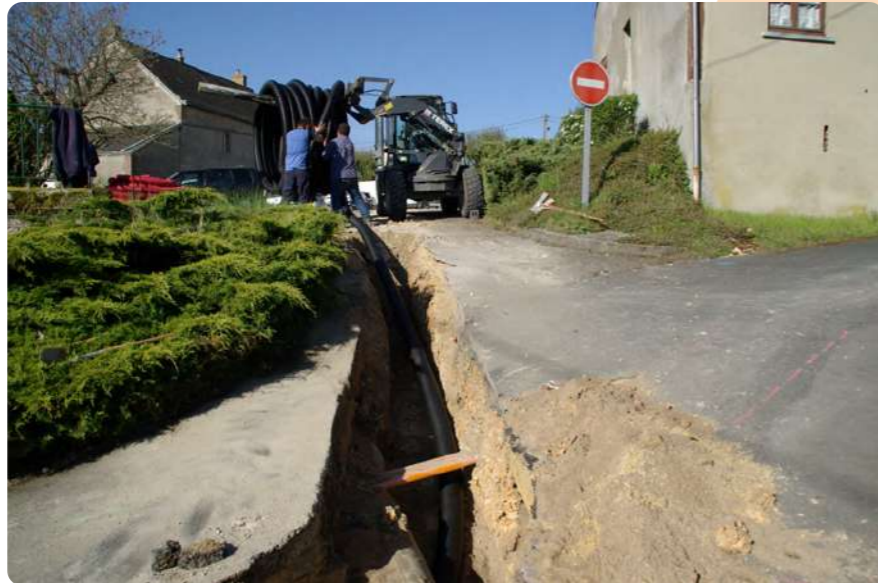
Travaux d'installation du chauffage par géothermie dans la commune de Saunay (© Mairie de Saunay)
